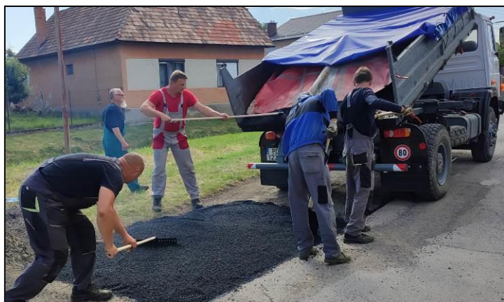
Foto: archív OcÚ. Asfaltovanie ciest svojpomocne v Ješkovej Vsi.
