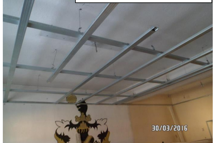
foto: archív OcÚ, rekonštrukcia obecného úradu
