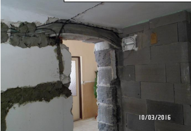
foto: archív OcÚ, rekonštrukcia obecného úradu
